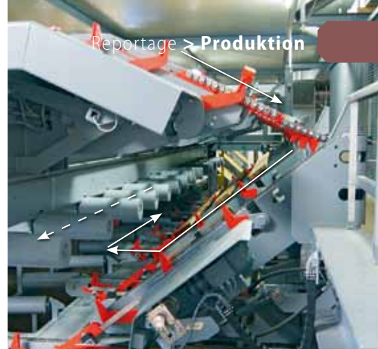
KVH oder Hobelware: Von oben kommt Rohware, welche über die obere Rollenbahn zur KVH-Anlage läuft oder nach unten zur Hobelung
