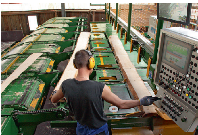
Beurteilungsdeck: Mitarbeiter kann Schwarten mittels Klappe ausschleusen beziehungsweise Schwartenanläufe auskappen
