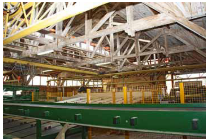
Enge Platzverhältnisse: Halle und der Dachstuhl mit Fachwerk aus 1928 konnten überwiegend erhalten bleiben
